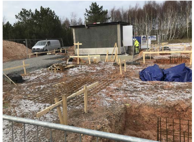
Pågående markarbeten i Höganäs.
