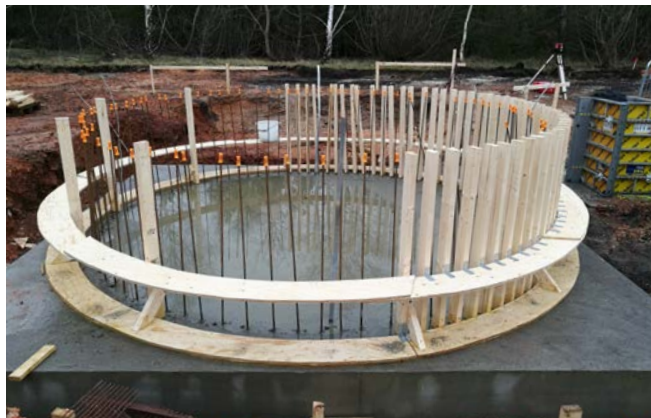
Betongfundament för förgasningsreaktor
