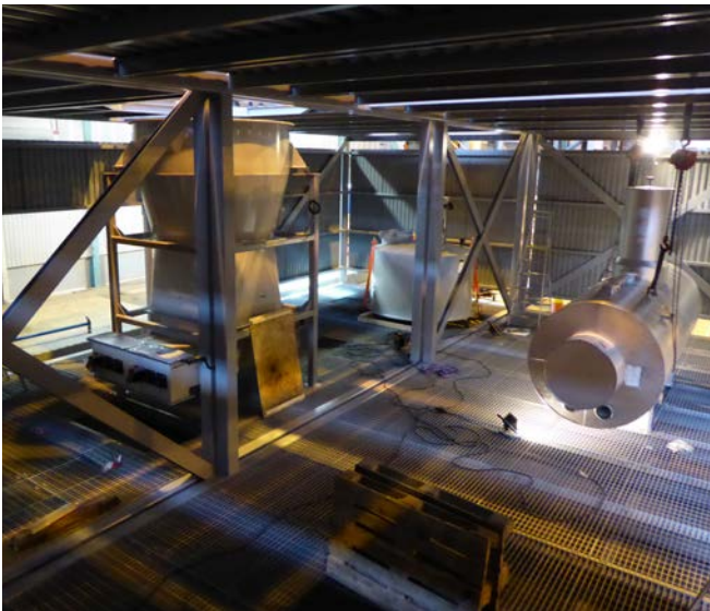
Bild från montagearbete från våning tre i modulen. Foto: Erik Nygren.
