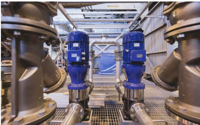
Pågående montagearbete av moduler i Karlstad. Foto: Erik Nygren.
