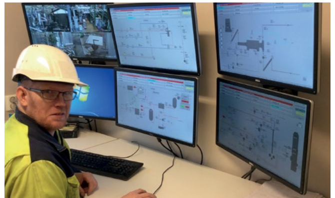
Integrerad drift i Köping november 2015. Med fjärrövervakning kan anläggningen i framtiden köras obemannad.
